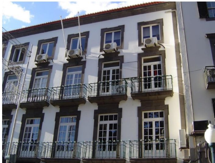
Figura 2 – Edifício onde se encontravam as instalações da Saneamento Básico, na Rua do Aljube
