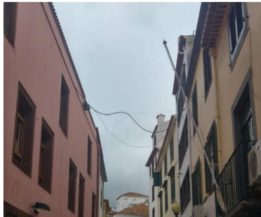
Figura 8 – Cabo de ligação entre as instalações da Rua do Aljube e Queimada de Baixo
