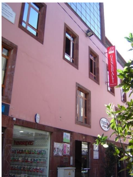
Figura 3 – Edifício onde se encontravam as instalações da Direção Regional do Saneamento Básico, na Rua da Queimada de Cima
