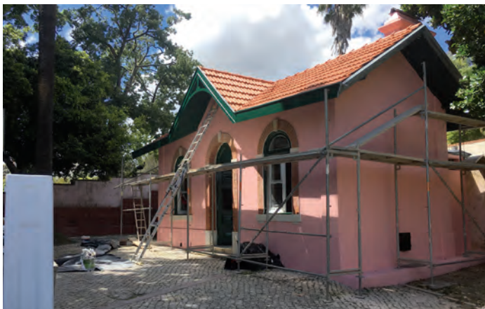
Fig. 5.8 – Chalet de entrada do Jardim Botânico da Ajuda da Calçada da Ajuda (obras de recuperação). Chalet at the Calçada da Ajuda entrance to the Ajuda Botanical Garden (recovery work). (© A.L. Soares)
