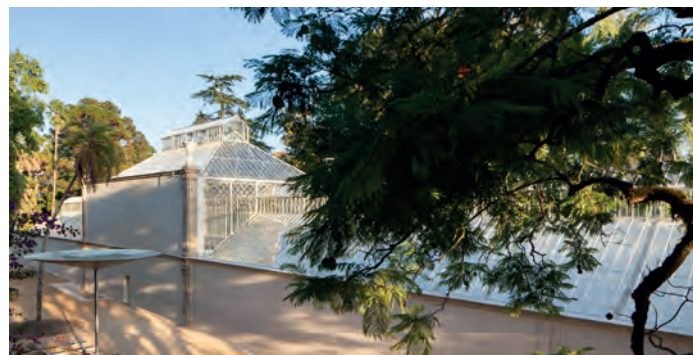
Fig. 3.74 – Patamar junto à estufa tropical do Jardim Botânico da Universidade de Coimbra, onde se pode ver um chapéu coletor de água da chuva que é armazenada em depósitos subterrâneos para posterior utilização.
