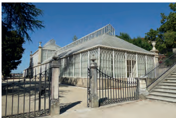
Fig. 1.12 – Estufa Tropical, concluída no séc. XIX; de feição neogótica e construída em ferro e vidro, é constituída por 3 salas dedicadas a coleções de diferentes proveniências e requisitos ambientais
