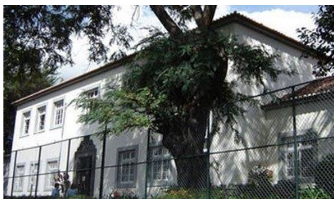
Figura 35 – EB1/PE Visconde Cacongo, Edifício 103
