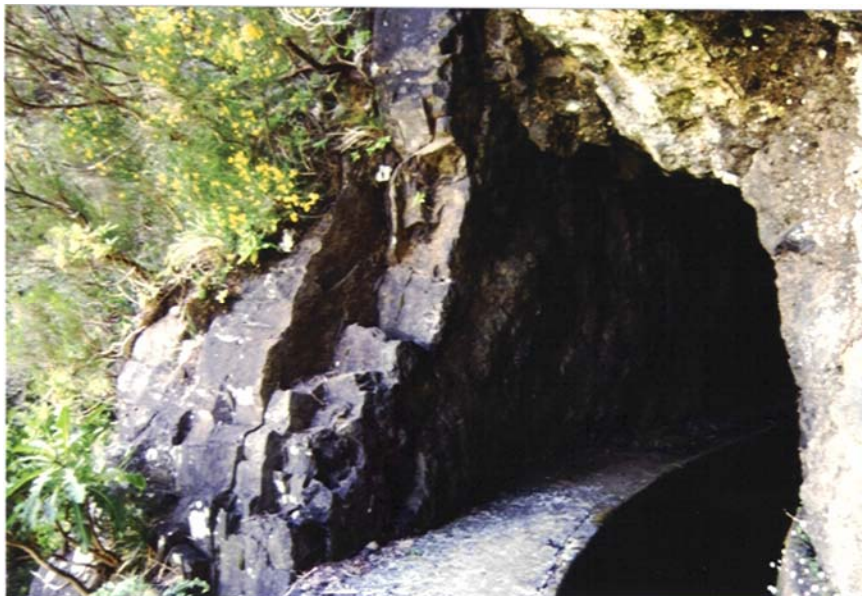
Figura 10 – Filão basáltico subvertical
