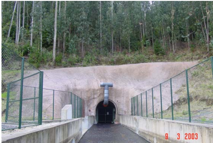
Figura 12 – Galeria de captação da Fajã da Ama.
