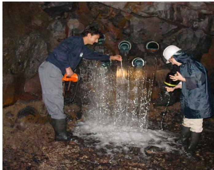
Figura 13 – Origem de uma galeria de captação.
