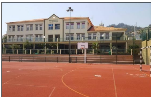
Figura 38 - Fachada da EB1/PE da Assomada
