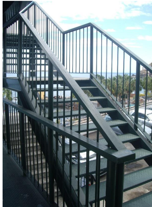
Figura D.8 – Escada metálica Hotel Penha França Mar, Funchal, Madeira
