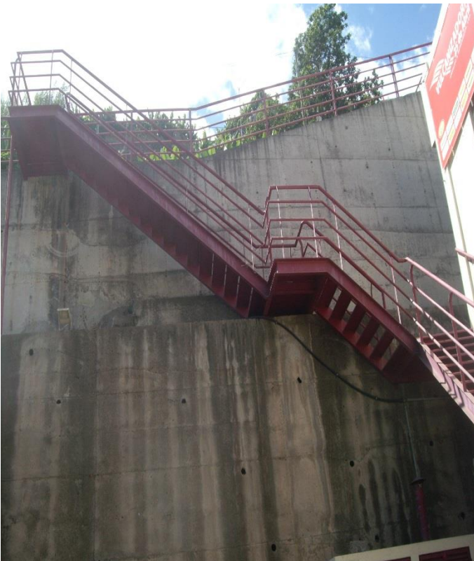
Figura D.15 – Escada metálica Vulcanizadora Parque Empresarial, Câmara de Lobos, Madeira
