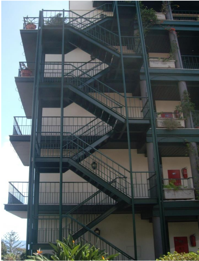
Figura D.9 – Escada metálica Reid's Gardens, Funchal, Madeira
