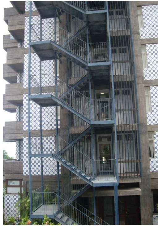
Figura D.6 – Escada metálica Aparthotel Gorgulho, Funchal, Madeira
