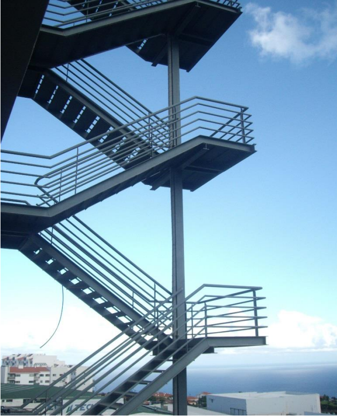
Figura D.13 – Escada metálica Maxmat, Caniço, Madeira
