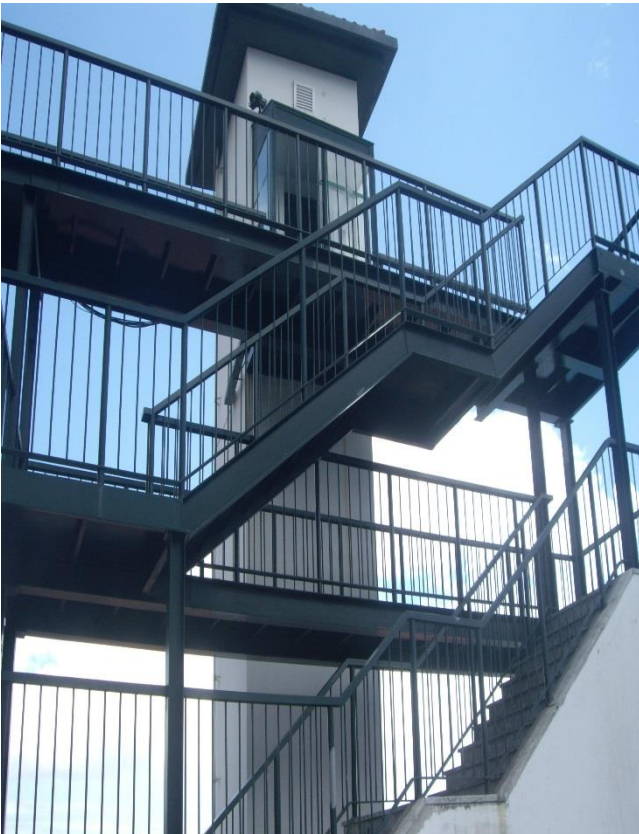
Figura D.7 – Escada metálica Hotel Penha França Mar, Funchal, Madeira
