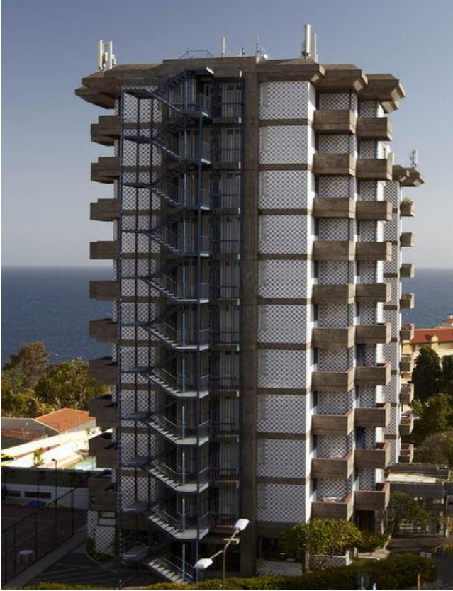
Figura D.5 – Escada metálica Aparthotel Gorgulho, Funchal, Madeira
