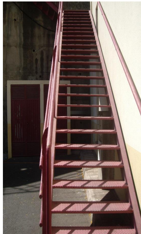
Figura D.16 – Escada metálica Vulcanizadora Parque Empresarial, Câmara de Lobos, Madeira
