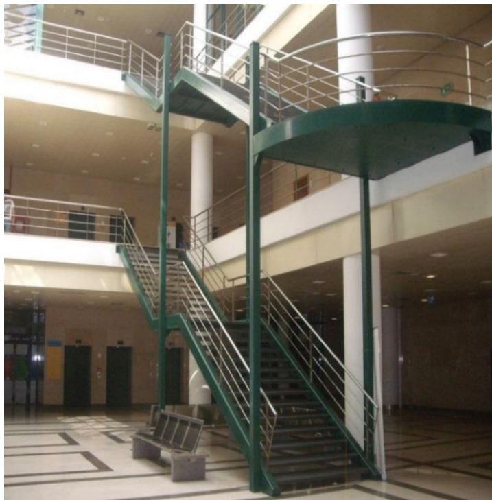
Figura 4.1 – Escadas metálicas Madeira Tecnopolo
