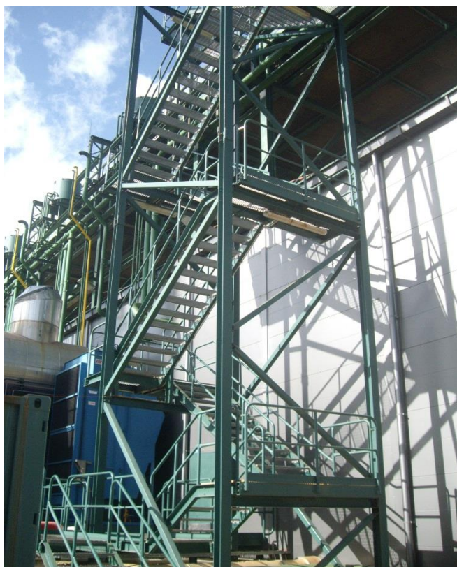
Figura D.21 – Escada metálica Empresa de Electricidade da Madeira (EEM), Câmara de Lobos
