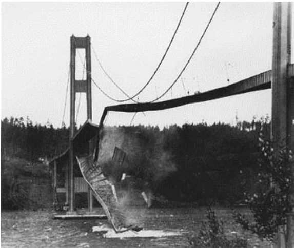
Figura 2.1 – Queda da ponte Tacoma Narrows, 1940, (Washington, Estados Unidos)
