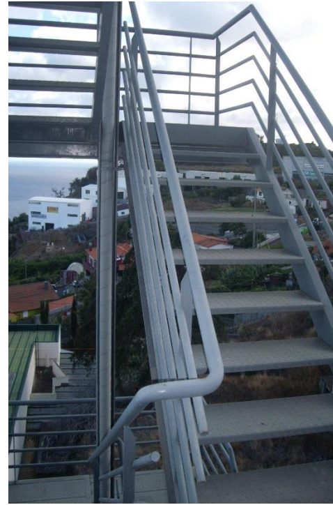
Figura D.14 – Escada metálica Maxmat, Caniço, Madeira
