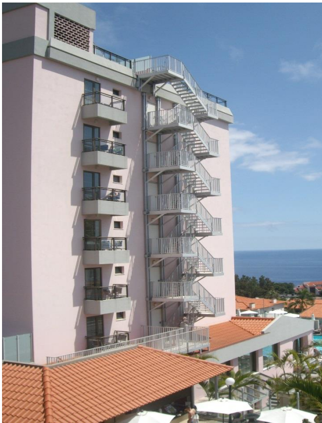
Figura D.11 – Escada metálica Savoy's Gardens, Funchal, Madeira
