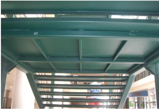
Figura C.2 – Pormenor dos perfis metálicos tubulares no patamar intermédio
