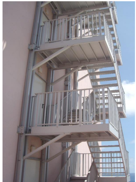
Figura D.12 – Escada metálica Savoy's Gardens, Funchal, Madeira
