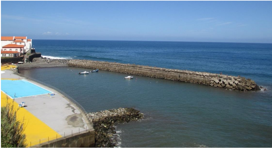
Figura 5 - Quebramar de proteção da zona balnear de Ponta Delgada (julho de 2013).
