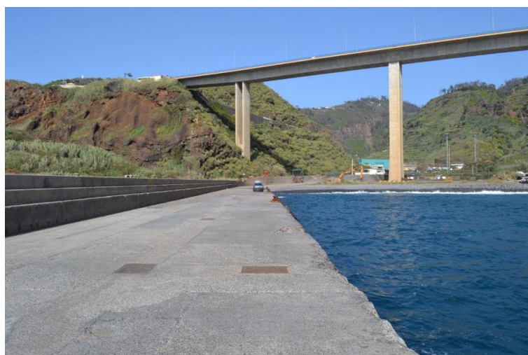
Figura 5 - Superestrutura com muro cortina (abril de 2013).
