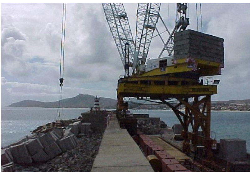
Figura 6 - Grua de grande capacidade Manitowock 4100 , com deslocação sobre carris.
