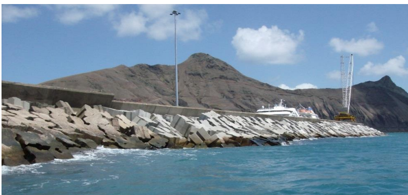
Figura 7 - Trabalhos concluídos no manto resistente do porto do Porto Santo.
