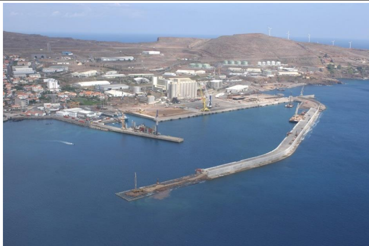
Figura 5 - Construção do molhe exterior do porto do Caniçal.
