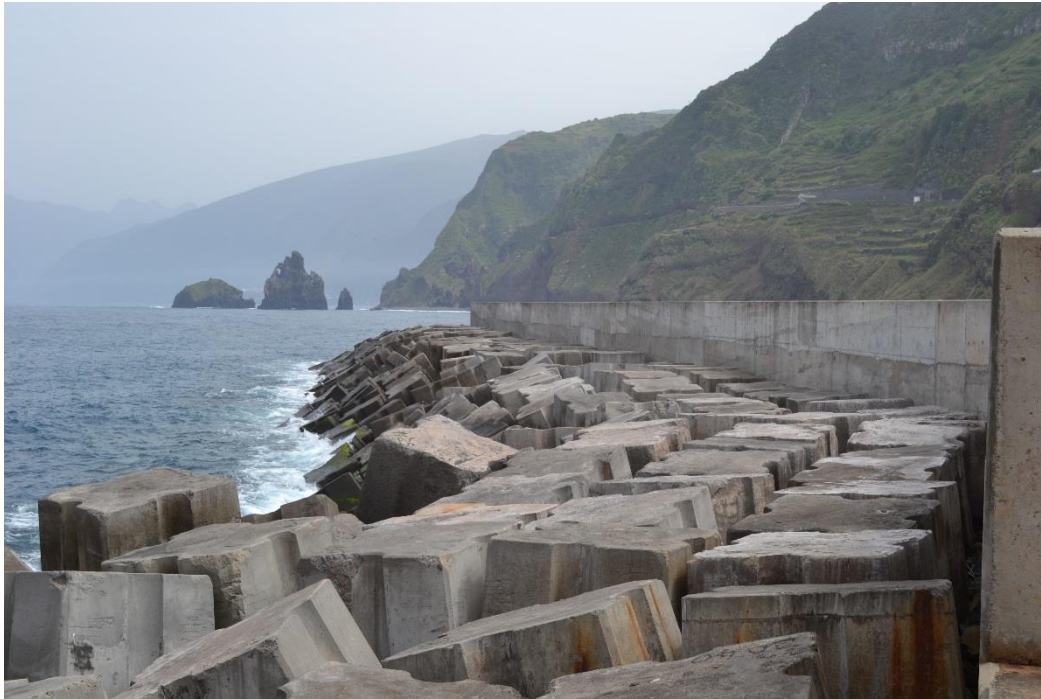
Figura 2.14 – Manto resistente do Porto de Abrigo do Porto Moniz.
