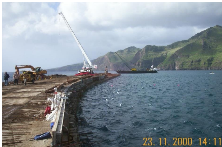
Figura 6 - Construção da superestrutura, do molhe exterior do porto do Caniçal.
