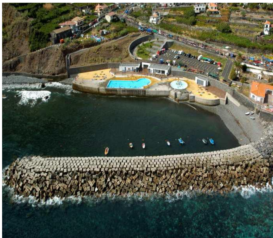
Figura 4 - Proteção da zona balnear de Ponta Delgada.
