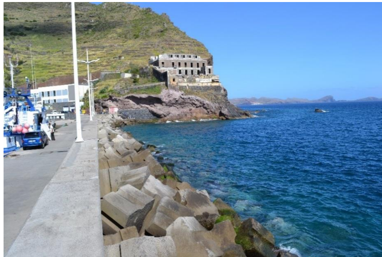
Figura 6 - Manto resistente composto por blocos cúbicos "Antifer", troço 1 (abril de2013).
