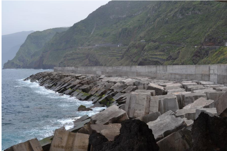
Figura 5 - Manto resistente constituído por blocos "Antifer" (fevereiro de 2013).
