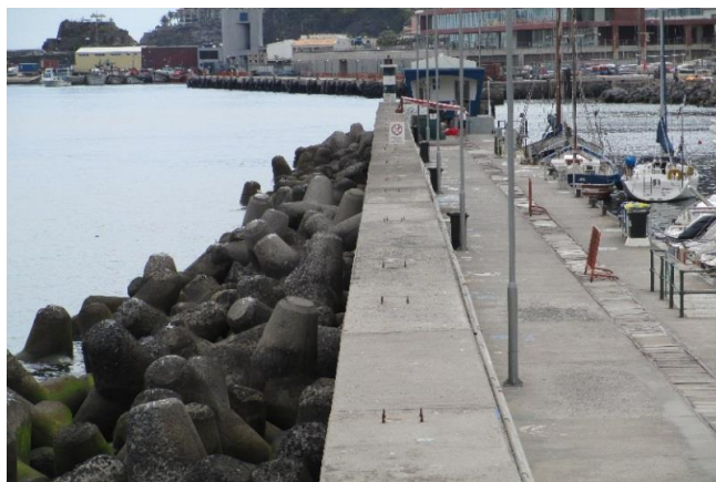
Figura 5 - Superestrutura e manto resistente (junho de 2013).
