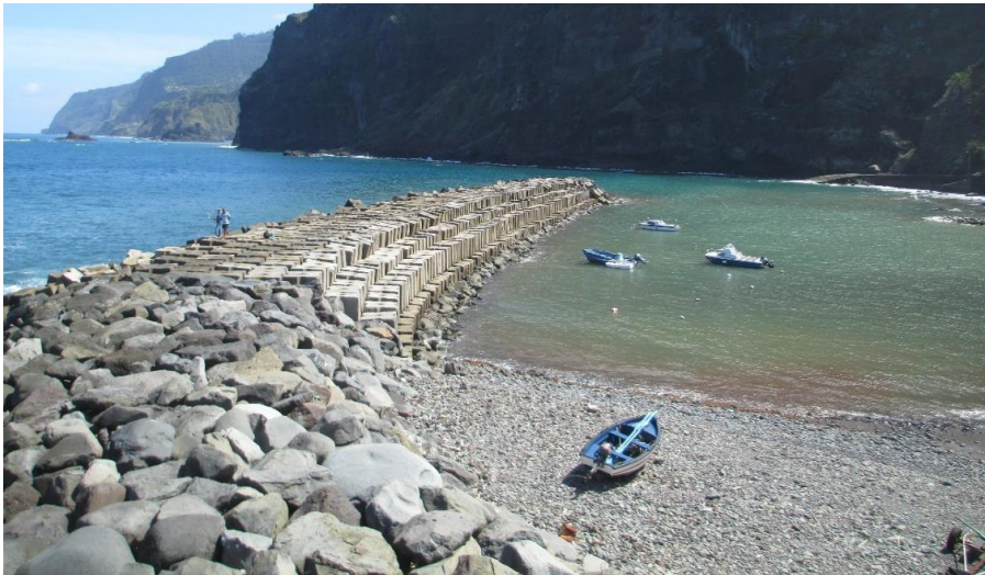
Figura 6 - Enraizamento e bacia proporcionada pelo quebramar (julho de 2013).
