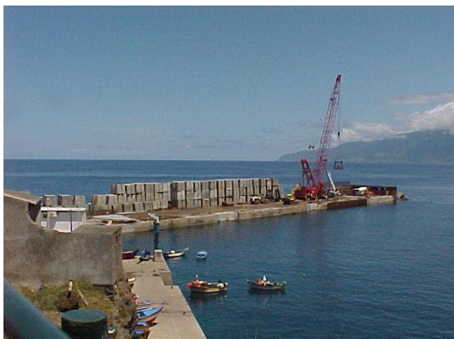
Figura 9 - Colocação dos blocos "Antifer", na cabeça do quebramar.
