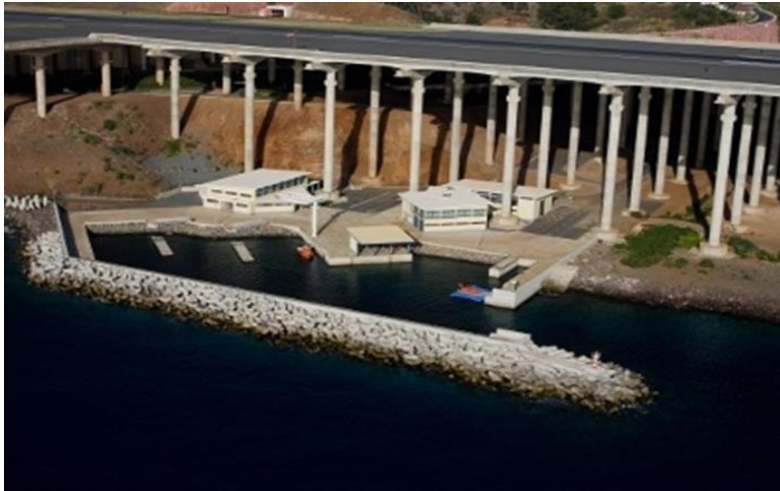
Figura 5 - Vista aérea da estrutura (abril 2013).
