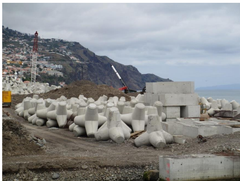
Figura 1.5 – Armazenamento dos tetrápodes antes da sua colocação.
