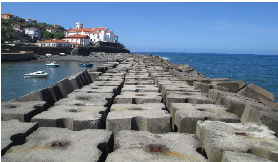
Figura 7 - Coroamento do quebramar de proteção (julho de 2013).
