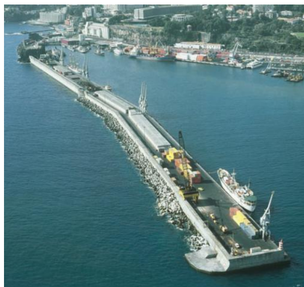
Figura 10 - Reparação do lado exterior do porto (1991-1997).
