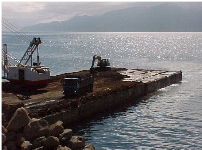
Figura 8 - Enchimento dos caixotões.
