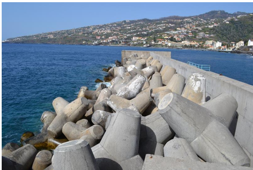
Figura 2.11 – Manto resistente do Porto de Abrigo do Posto de Socorros a Naufragos (Santa Cruz).
