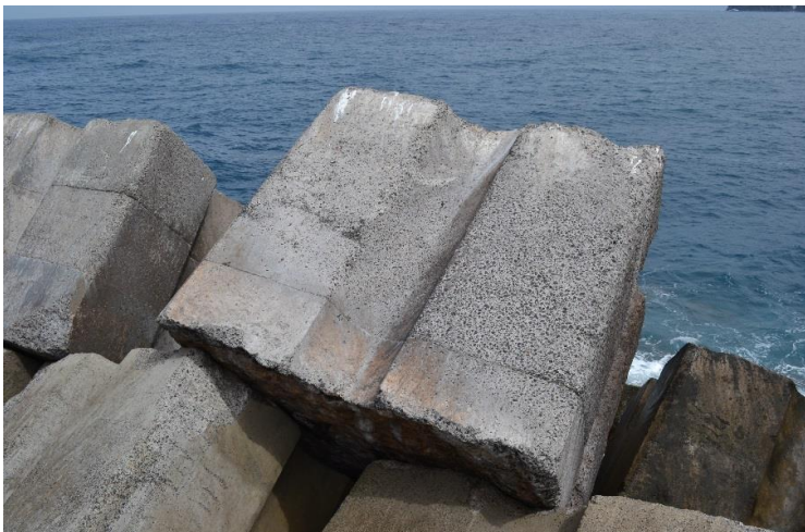
Figura 7 - Bloco "Antifer" de 50 toneladas (fevereiro de 2013).
