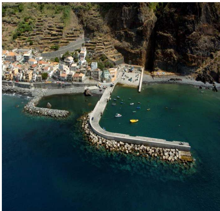
Figura 4 - Vista aérea do cais acostável do Paúl do Mar.
