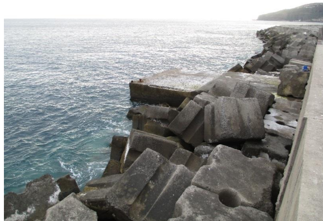
Figura 6 - Manto resistente constituído por blocos "Antifer" (maio de 2013).
