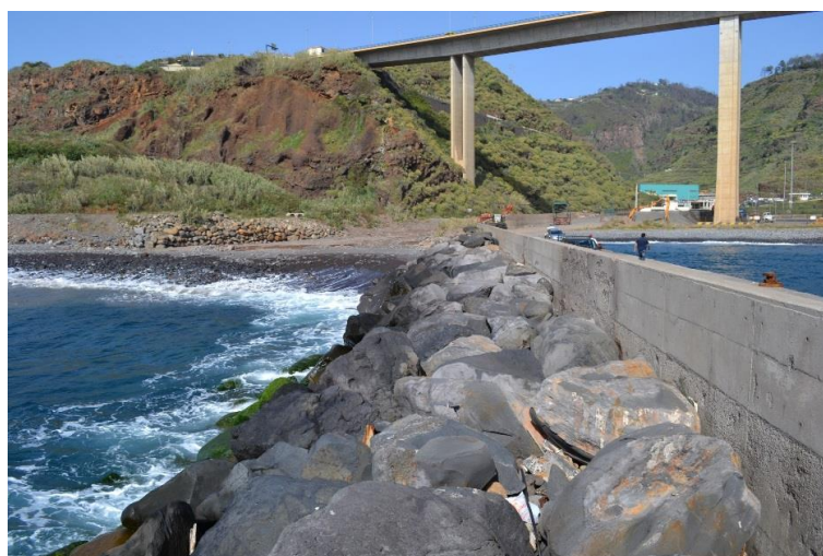
Figura 4 -Manto resistente constituído por enrocamento (abril de 2013).
