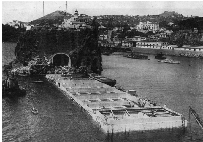
Figura 8 - Primeiros caixões de enchimento da 3ª fase (1934-1939 - 3ª fase do porto).
