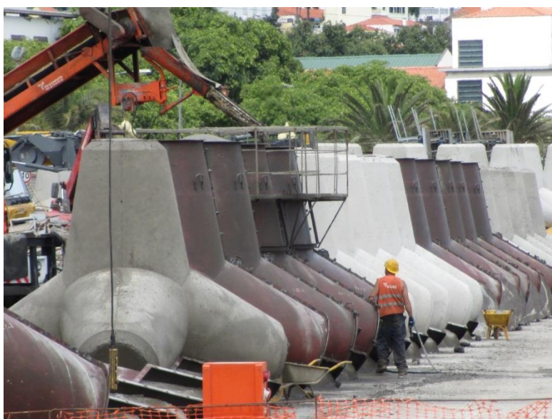
Figura 1.4 – Fase de enchimento do molde com betão.
