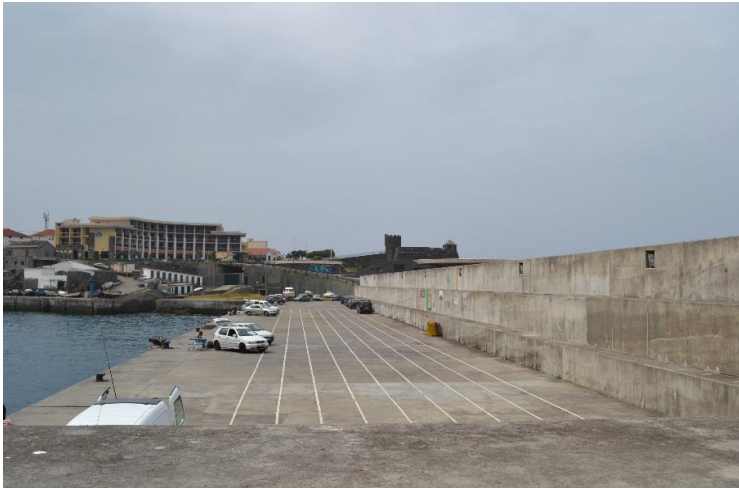
Figura 6 - Superestrutura com muro cortina (fevereiro de 2013).
