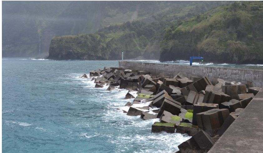
Figura 6 - Manto resistente constituído por blocos "Antifer" (fevereiro de 2013).
