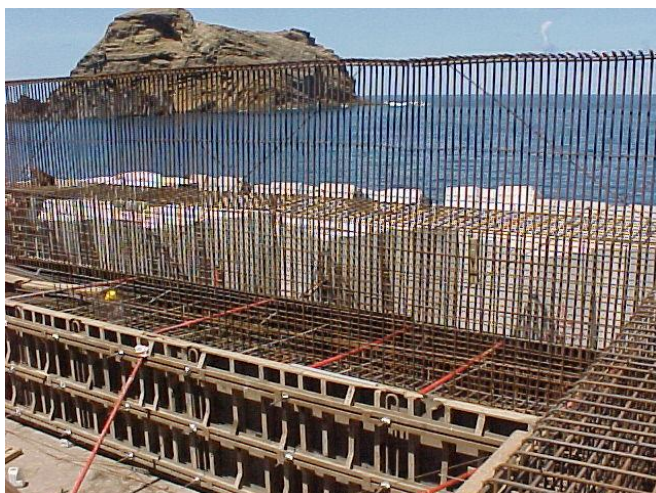
Figura 10 - Construção do muro cortina.
