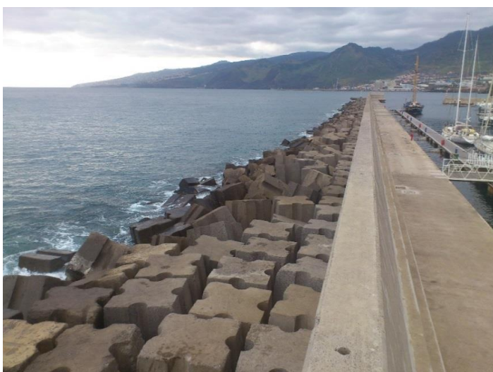
Figura 7 - Manto resistente composto por blocos cúbicos "Antifer" (abril de 2013).
