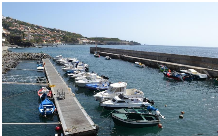
Figura 4 - Interior da bacia do porto de recreio de Santa Cruz, vista 1 (maio de 2013).
