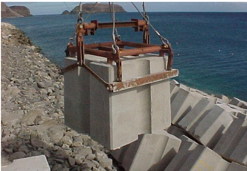
Figura 5 - Colocação dos blocos "Antifer", no manto resistente.
