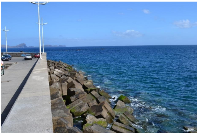
Figura 7 - Manto resistente composto por blocos cúbicos "Antifer", troço 2 (abril de2013).
