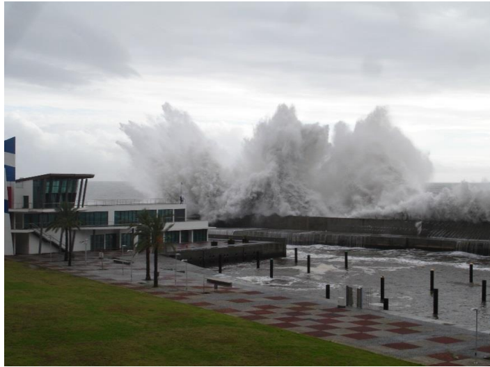
Figura 5 - Incidência da agitação marítima no quebramar do molhe exterior da marina (2011).
