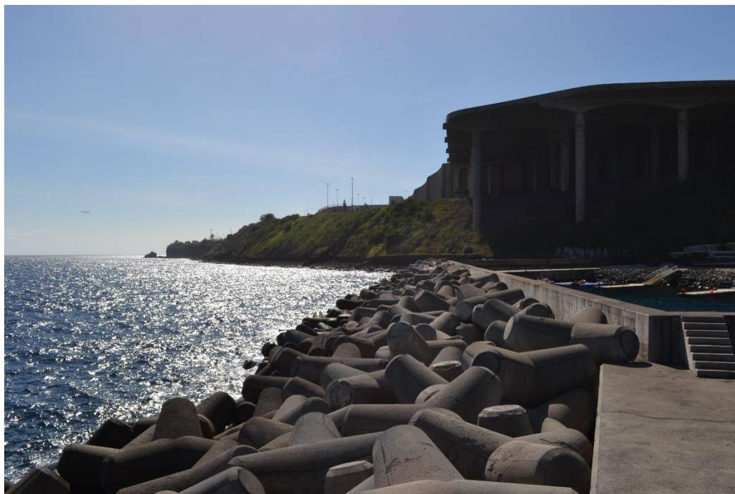
Figura 2.12 – Manto resistente do Cais Acostável de Santa Cruz.
