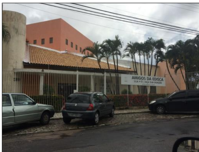
Foto 12 - Fachada da escola
