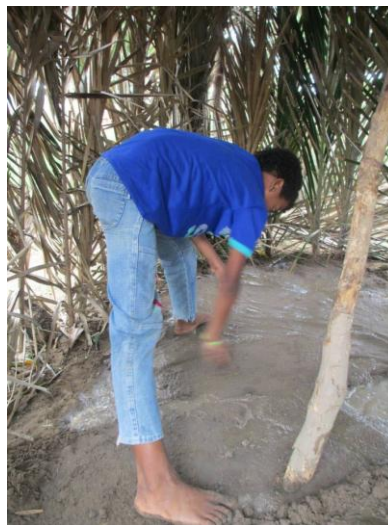
Figura 8: Construção da própria casa 3 Fotografia: Ana Carolina Novaes
