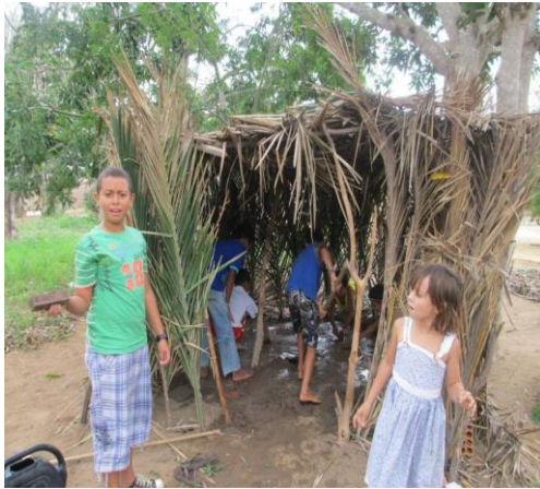
Figura 6: Construção da própria casa 1 Fotografia: Ana Carolina Novaes
