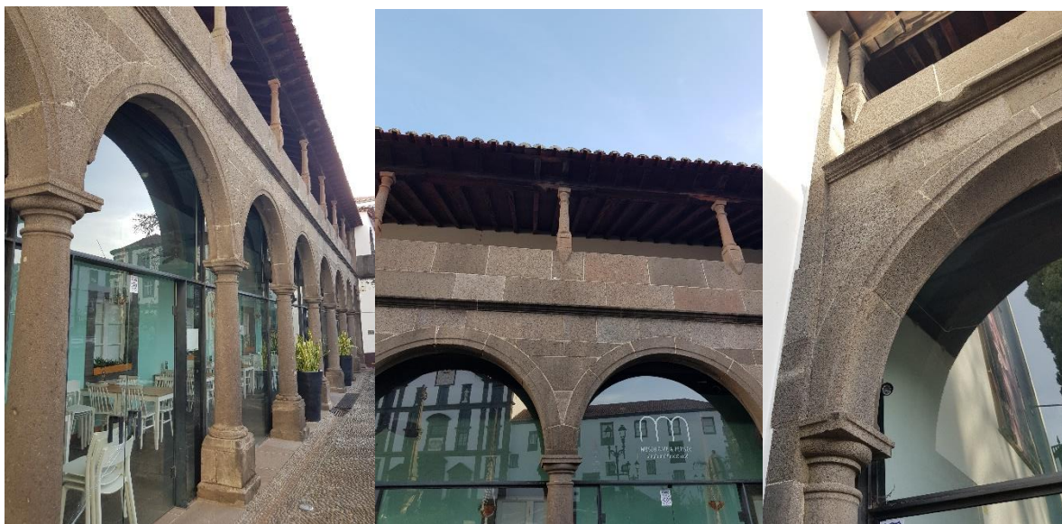
Figura 1 – MASF (Pórtico coberto sustentado por colunas e arcos de volta perfeita)
