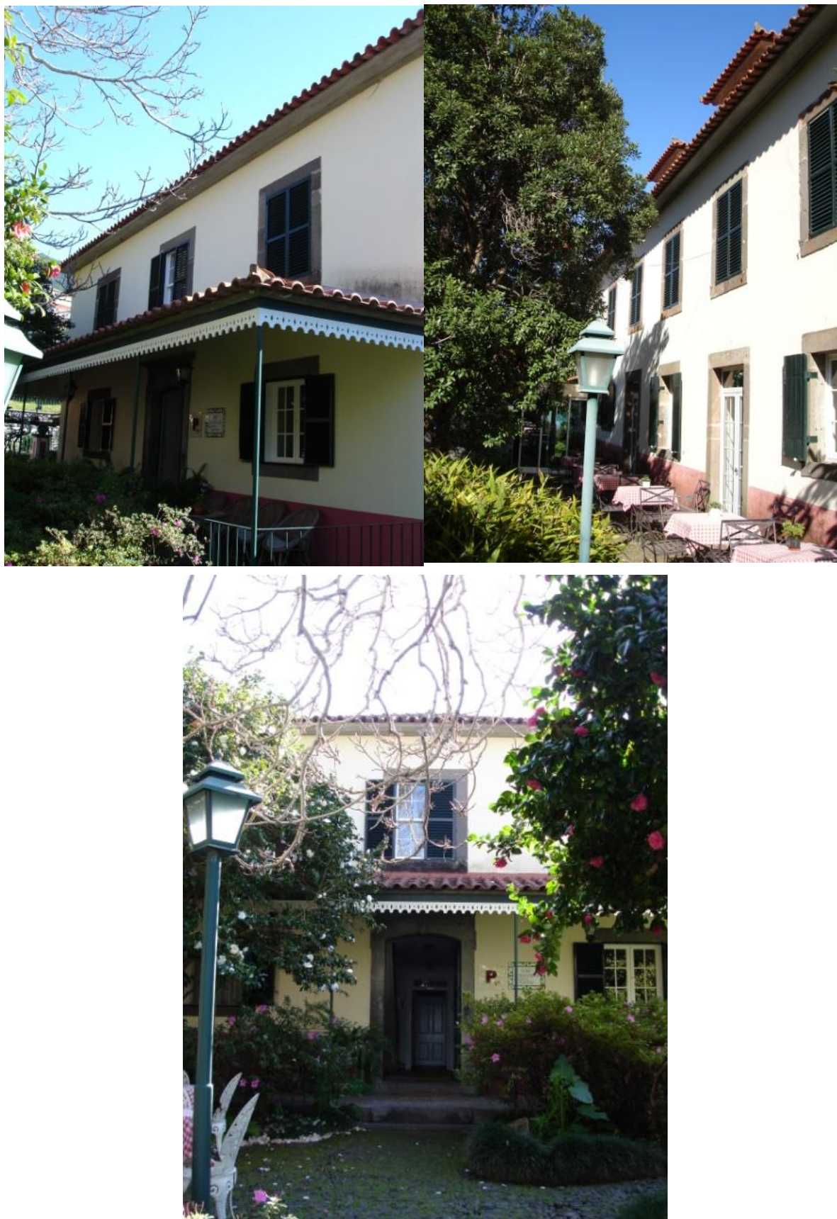
Fig. 48 – Solar da Boaventura, São Vicente (Autoria própria)
