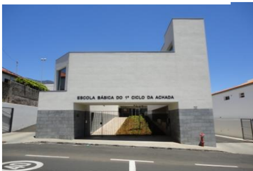
Figura 3: Vista frontal da EB1/PE da Achada
