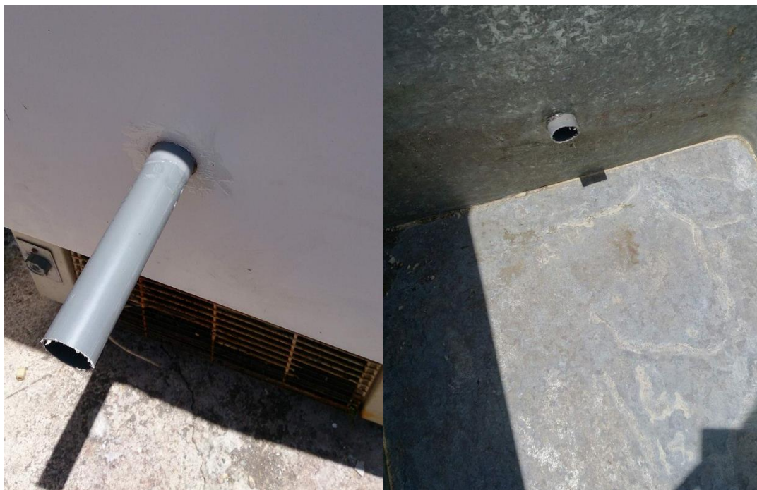
Figura 49 Preparação das juntas dos furos da arca
