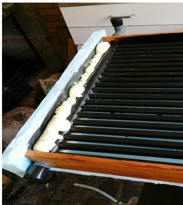
Figura 46 Preenchimento das juntas com espuma isoladora
