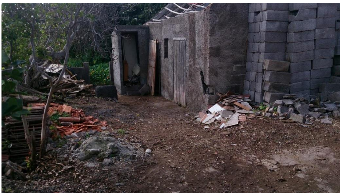
Figura 31 Moradia por Reabilitar
