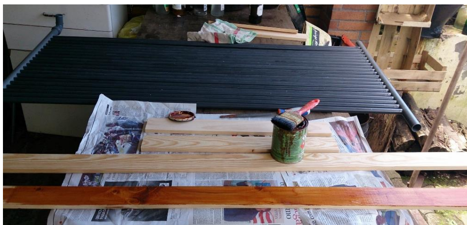
Figura 45 Preparação da estrutura de madeira com Bondex®
