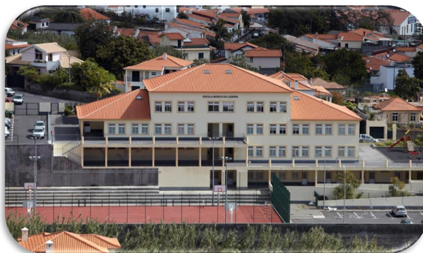
FIGURA 27 - ESCOLA EB1 PE DA LADEIRA
