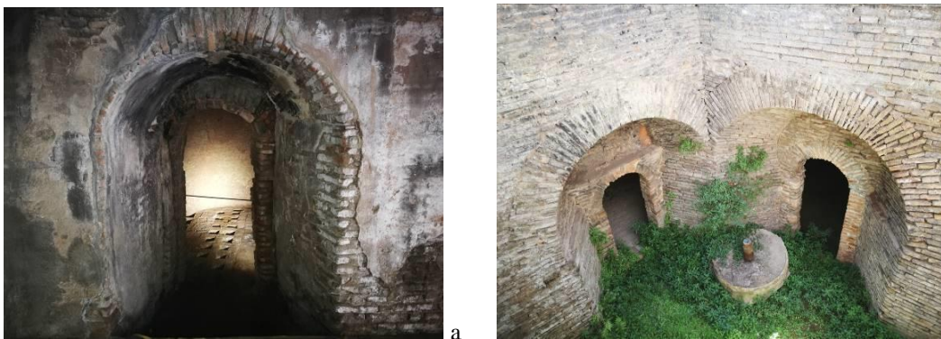
Fig. 13. a. Entrada da câmara de cozedura onde eram cozidas as peças cerâmicas; b. Entrada da fornalha. Fábrica de cerâmica musealizada no Centro Cerâmico de Triana , em Sevilha (foto: LG).
