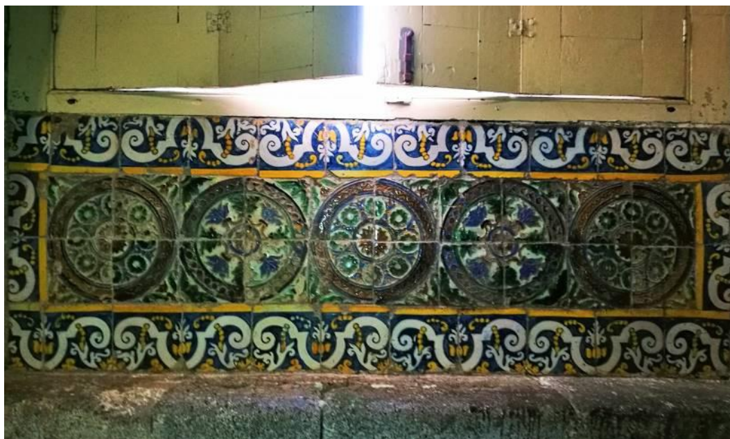
Fig. 75. Na sacristia da Igreja Matriz de Santa Cruz, conseguimos verificar a existência de 20 azulejos hispano-árabes do séc. XVI, correspondentes a dois módulos compostos por quatro azulejos que formam padrões de inspiração renascentista. O conjunto está cercado por um padrão do séc. XVII, e todos são provenientes do antigo Convento da Nossa Senhora da Piedade de Santa Cruz (foto: LG).
