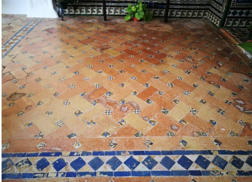
Fig. 47. Pavimento com composição constituída por Losetas na técnica de aresta, 6,5 x 6,5 cm e tijoleiras retangulares no claustro do Convento de Santa Clara de Carmona, na província de Sevilha (foto: © LG).
