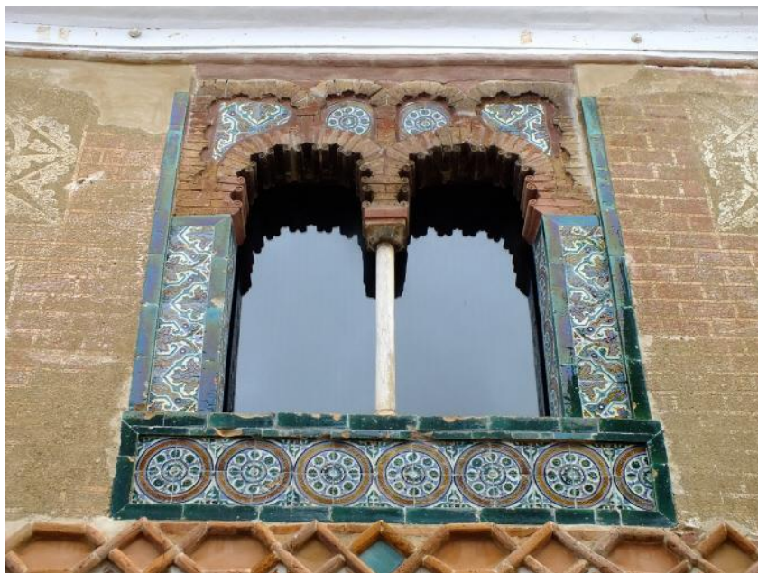
Fig. 32. Foi comum a aplicação de azulejaria hispano-árabe em fachadas exteriores, neste caso, com azulejos de aresta, no janelão da Casa del Ajimez, Calle de las Boticas, em Zafra, província de Badajoz (foto: © LG).
