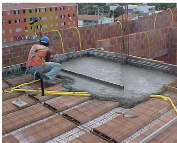
Figura 32 - Betonagem de uma laje de vigotas, (reproduzido de Junior, 2011).
