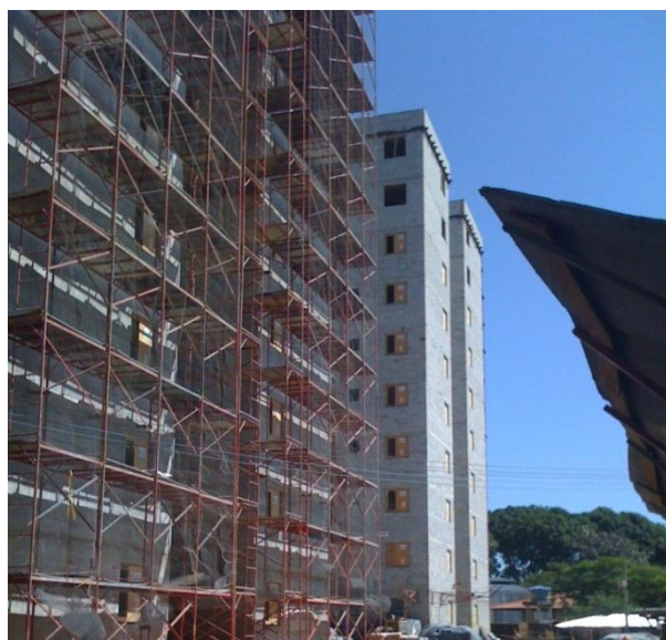
Figura 6 - Edifício com 10 pisos em construção, em Belo Horizonte, Brasil.
