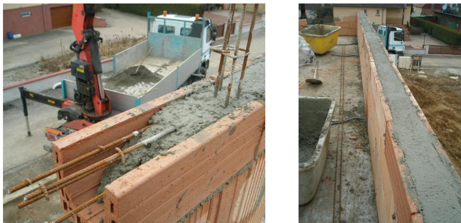
Figura 18 - Execução de uma viga de contorno para apoio da estrutura da cobertura.
