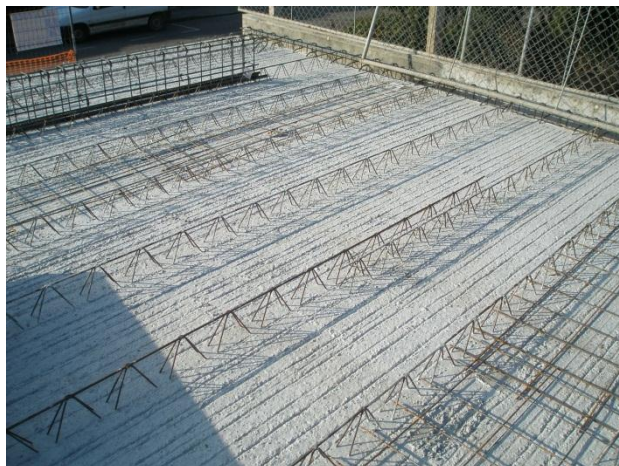
Figura 23 - Pré-lajes colocadas em edifício de 4 pisos.
