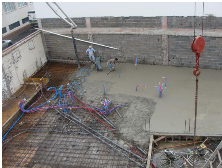
Figura 27 - Ensoleiramento geral aquando da betonagem.
