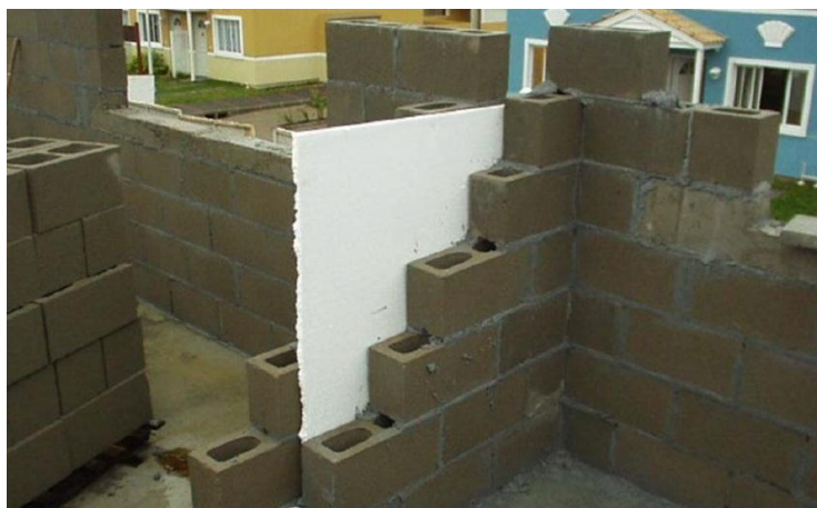
Figura 49 - Junta de dilatação em execução, (reproduzido de Santos M. D., 2004).
