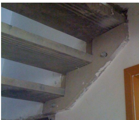
Figura 58 - Fixação com buchas, da escada pré-fabricada.
