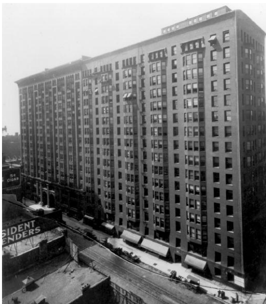
Figura 4 - Edifício Monadnock em Chicago, EUA, (reproduzido de Amrhein & Porter, 2009).
