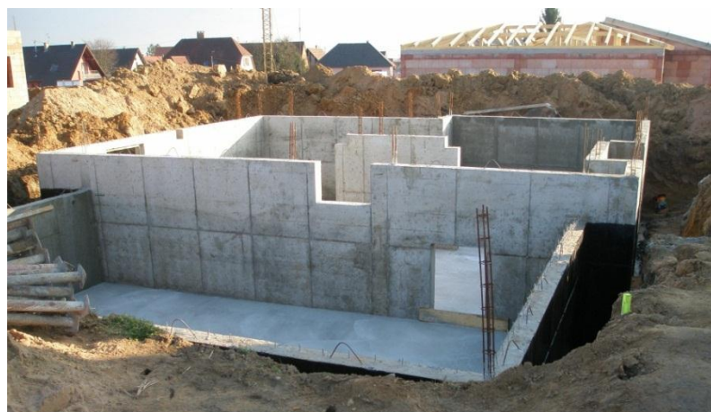
Figura 15 - Cave de uma moradia com paredes interiores e exteriores em betão armado.
