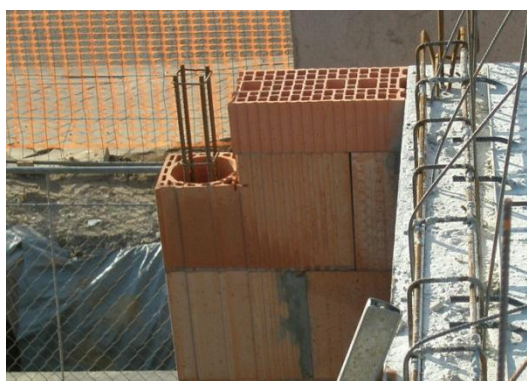
Figura 17 - Pormenor da armadura vertical para um pilar, no bloco cerâmico.
