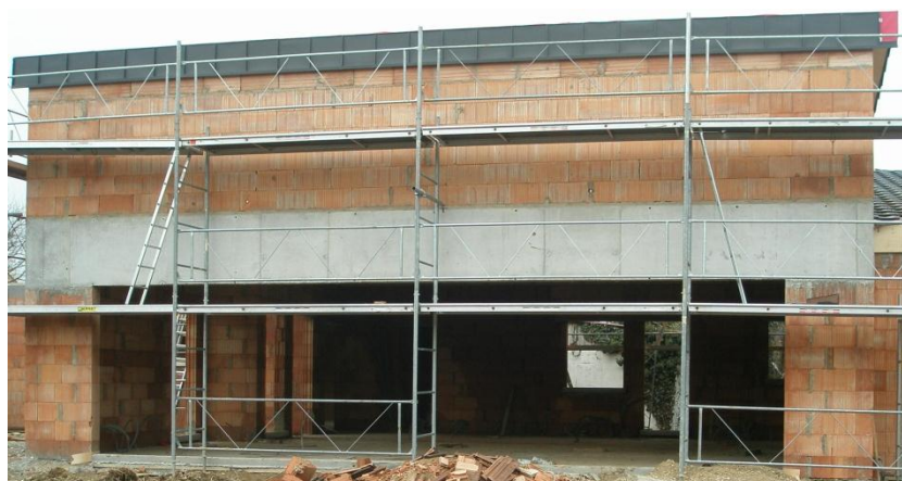
Figura 21 - Viga em betão armado, com 10 m de comprimento e executada in situ .
