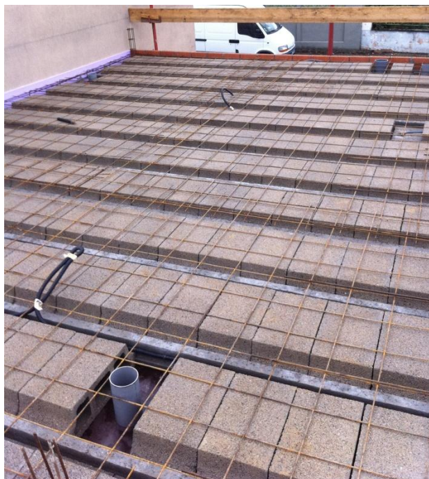
Figura 22- Laje de vigotas pronta para betonagem.
