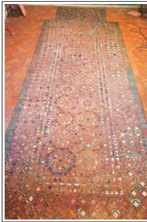
FIGURA 2.3. Sintra, Paço Real -Pavimento da capela, formado por uma composição de alicatado, ou mosaico cerâmico, polémico quanto à data e origem da técnica, possivelmente do séc. XV. Gravura extraída do livro "Azulejaria Portuguesa", p: 9 [?].
