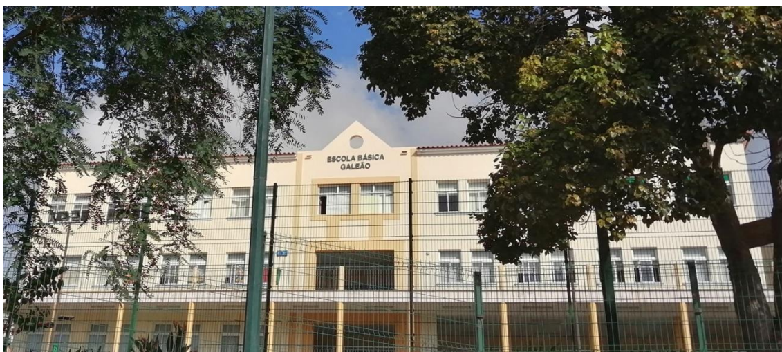
Figura 9: EB1/PE de São Roque - Edifício do Galeão
