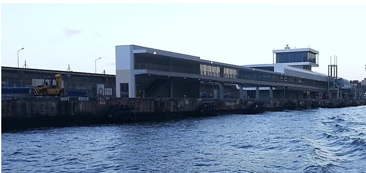
Figura 38 - Cais 3 - Parte Interior
