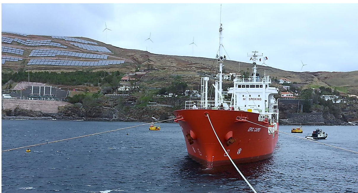
Figura 51 - Terminal de Combustíveis
