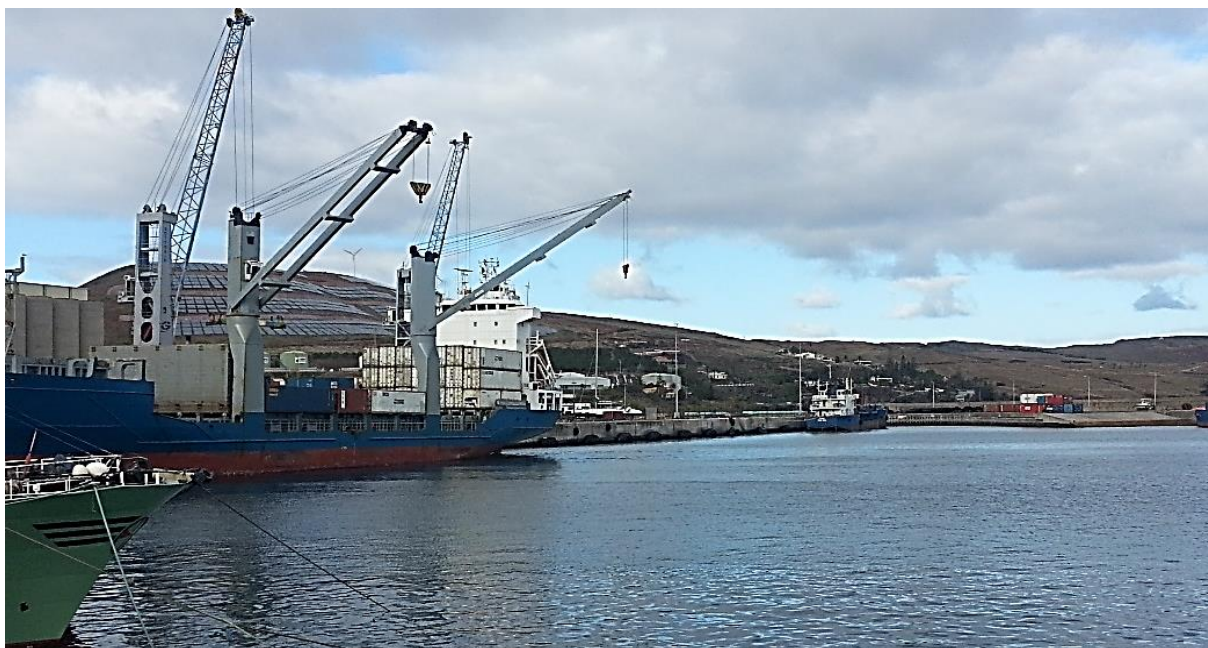
Figura 46 - Cais Norte (N)
