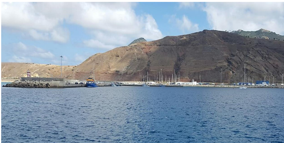
Figura 58 - Cais de Proteção do Porto Santo
