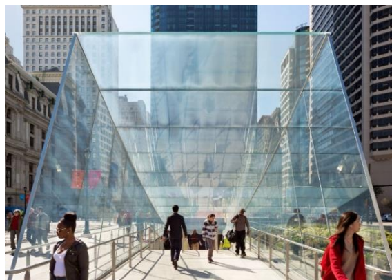
b) Vista para o interior da estrutura
