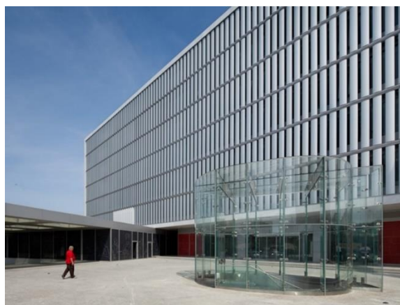
Figura 3.3: Sede da EDP no Porto, Portugal (APEL, s.d.)
