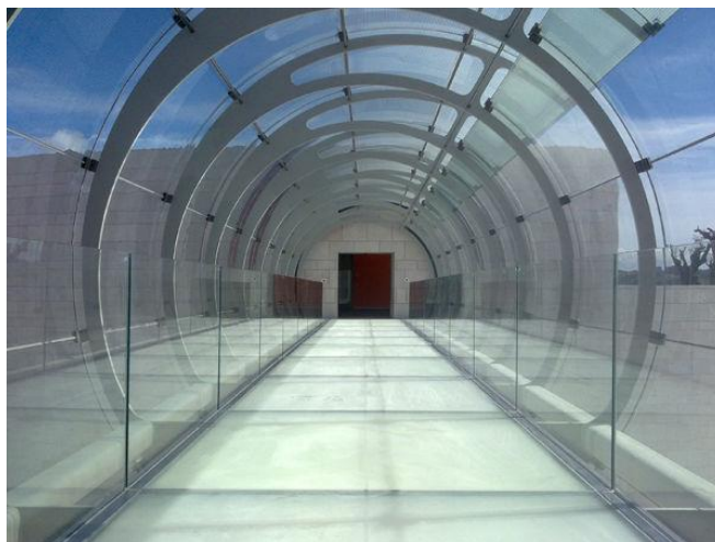
Figura 3.12: Interior da ponte que liga dois edifícios na Fundação Champalimaud em Lisboa, Portugal (Bellapart, s.d.)
