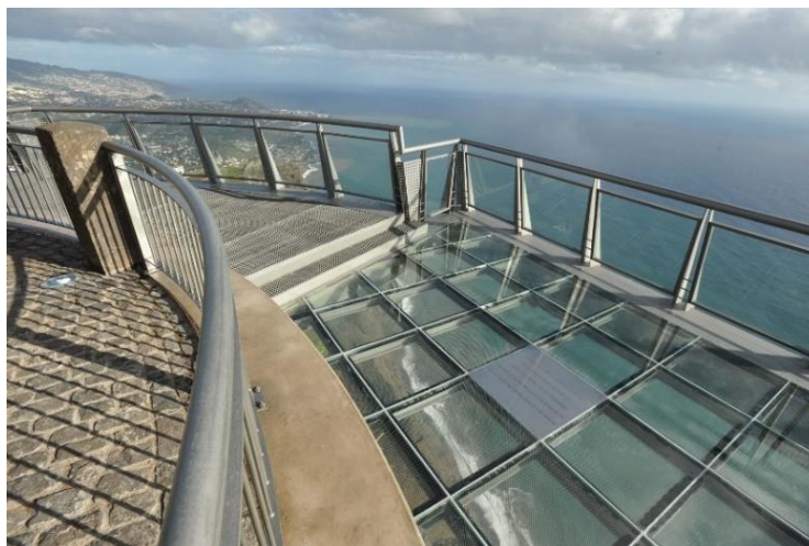
Figura 3.13: Pavimento em vidro no miradouro do Cabo Girão, Arquipélago da Madeira (Camacho, 2012)
