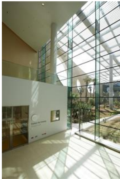
Figura 3.4: Glass fins utilizados numa fachada da Fundação Champalimaud em Lisboa, Portugal (Martifer, s.d.)
