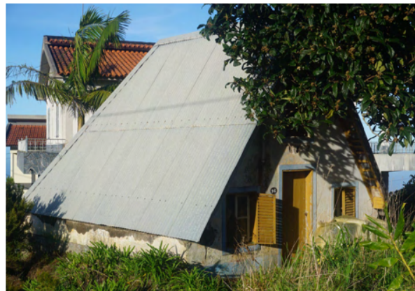
Figura 21: Exemplo de cobertura em chapas de zinco. (Joseph Caires). (2020). Santana.
