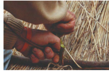
Figura 16: O aperto é feito com vime contra a armação de madeira. (2023). Santana Madeira Biosfera.
