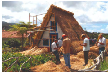
Figura 15: Processo para uniformizar os maranhos. (2023). Santana Madeira Biosfera.
