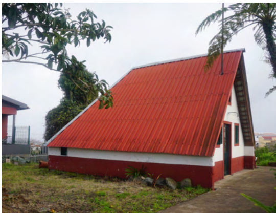
Figura 20: Exemplo de cobertura em chapas de zinco. (Joseph Caires). (2020). Santana.
