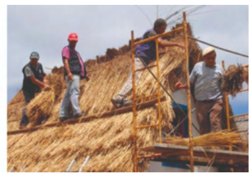
Figura 19: Processo de colmatação. (2023). Santana Madeira Biosfera.
