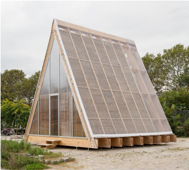
Figura 36: Dew catcher instalado no Vale de Moisés, Portugal. (Victoria Tanto). (2023).
