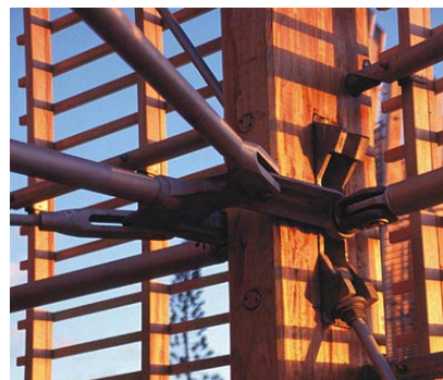
Figura 34: Ligações metálicas transversais. ( William Vassal). (2023).
