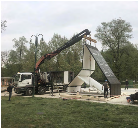
Figura 48: Processo de montagem em módulos. (M.A.D.i).(2023).
