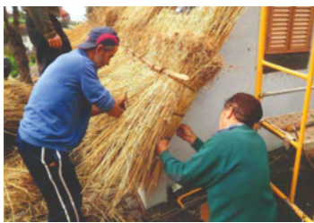
Figura 17: Colocação das primeiras camadas de palha. (2023). Santana Madeira Biosfera.
