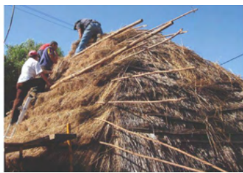
Figura 18: Varas horizontais, para compactar a cobertura. (2023). Santana Madeira Biosfera.
