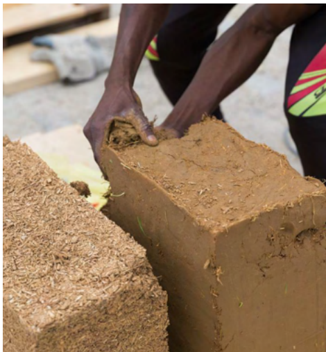
Figura 39: Vista da construção das paredes de adobe. (Victoria Tanto). (2023).
